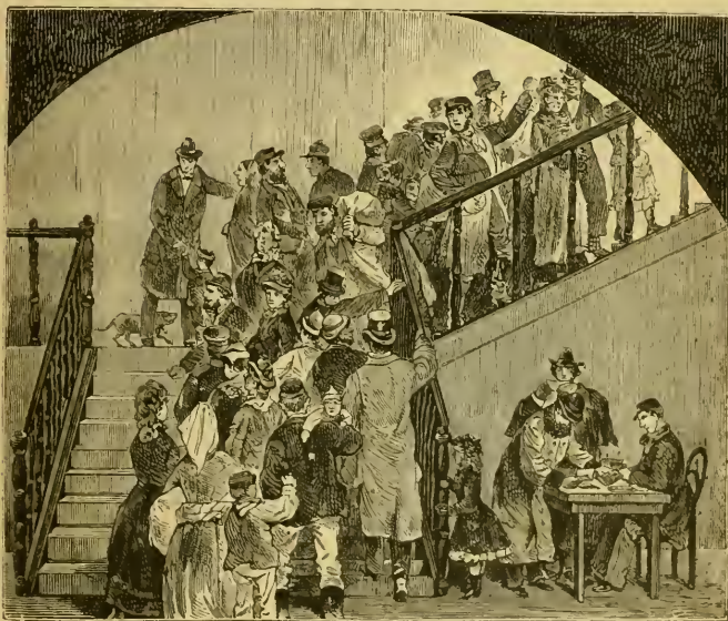
FIG. 177. — L'ESCALIER D'UNE STATION DU RAILWAY DE BERLIN
